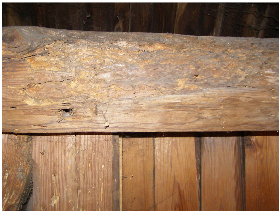
Fot. 59 - oczep ściany bocznej południowej - widoczny znaczny stopień destrukcji spowodowany żerowaniem spuszczela pospolitego
