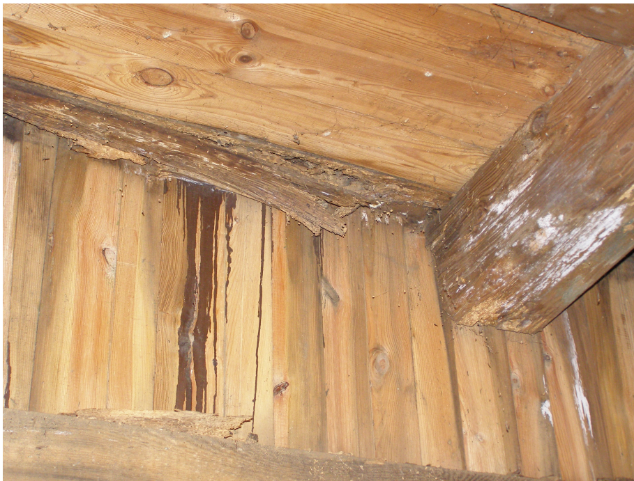
Fot. 158 - destrukcja końcówki belki stropowej oraz rygla ściany bocznej, północnej spowodowana kumulacją wilgoci między szalunkiem, a ryglem
