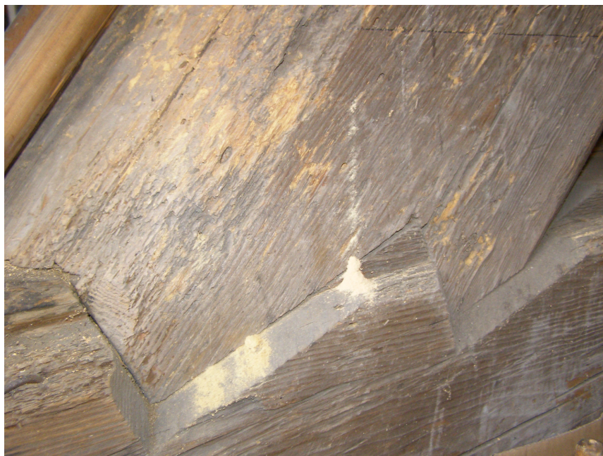
Fot. 149 - żerowiska spuszcza pospolitego we wschodnim zastrzale kozła
