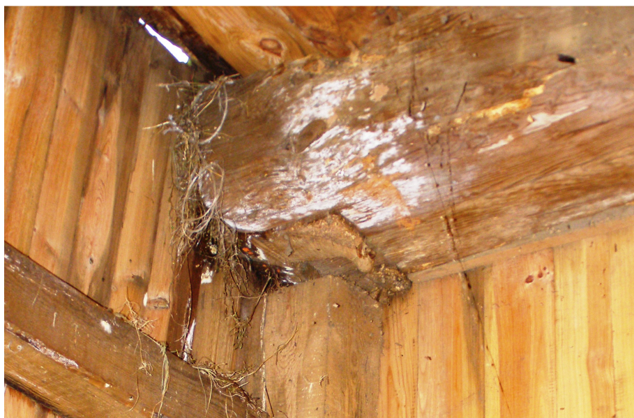
Fot. 159 - zawilgocenie i grzybnia podskórnik zatonowatego widoczna na końcówce naproźnicy (narożnik północno - wschodni); widoczne odcięcie pierwotnego słupa narożnego i zastąpienie go wtórnym słupem o mniejszym przekroju (ponadto występuje brak ciągłości / połączenia obu elementów)
